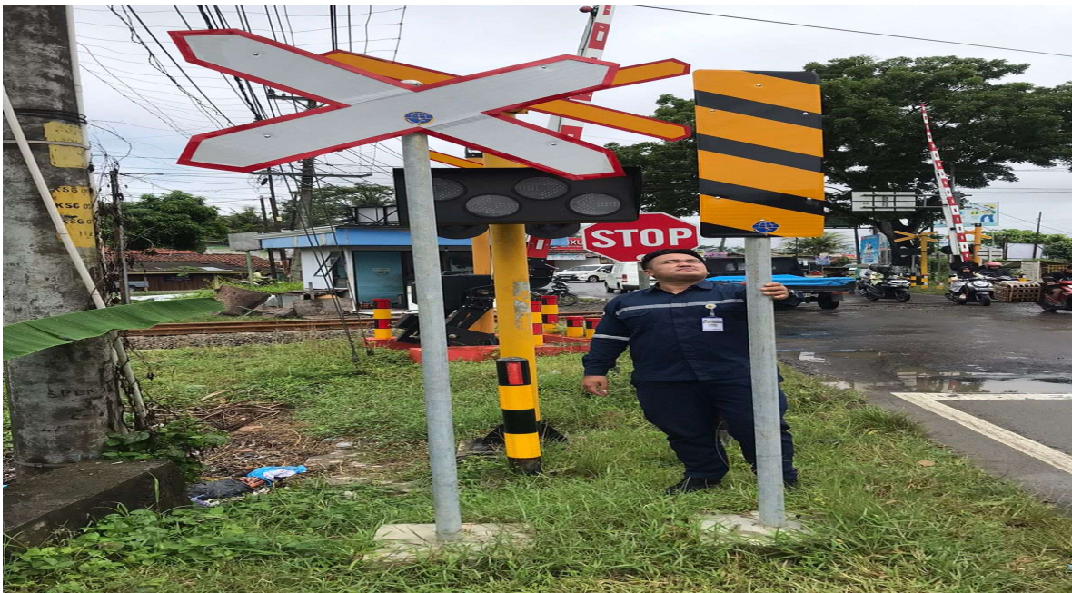
Gambar 3. 5 Pemasangan Rambu Peringatan
