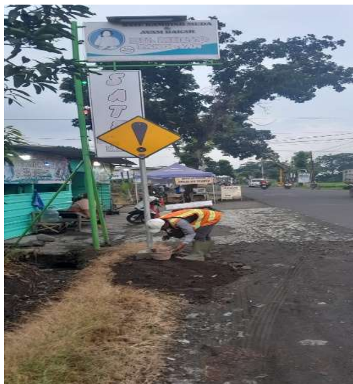
Gambar 3. 2 Pemasangan Perlengkapan Jalan
