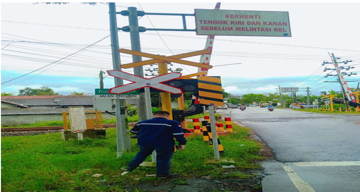
Gambar 3. 6 Pemasangan Rambu Cross Andrea
