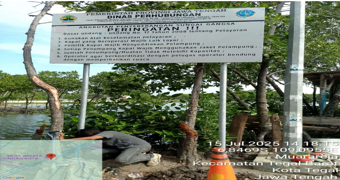
Gambar 3. 4 Pemasangan Rambu Peringatan Keselamatan Penyeberangan Sungai
