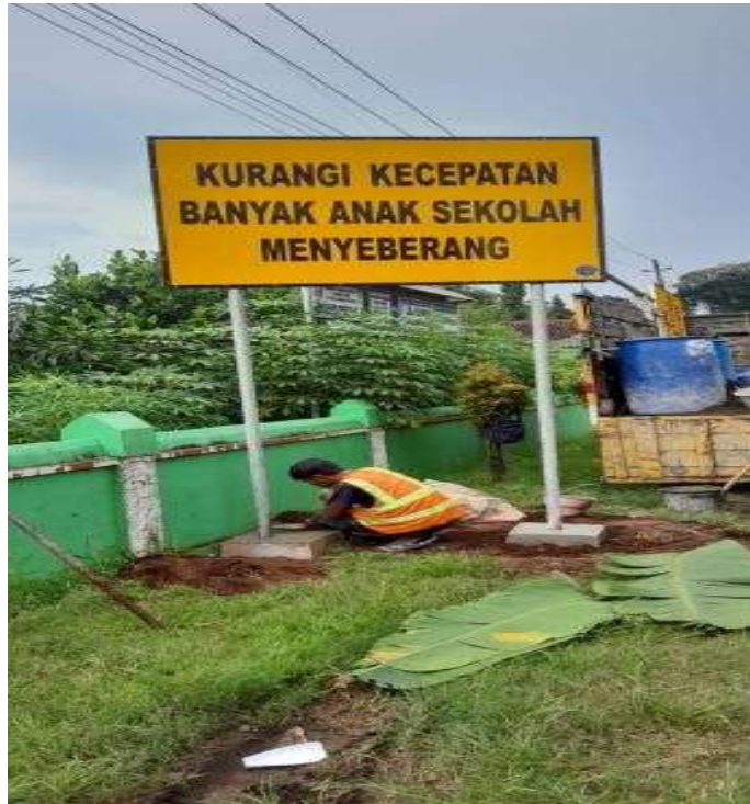
Gambar 3. 1 Rehabilitasi Daerah Rawan Kecelakaan
